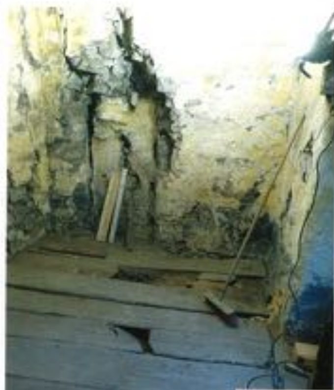
Torzimmer mit Resten des Zugangs zum damaligen Wehrgang
