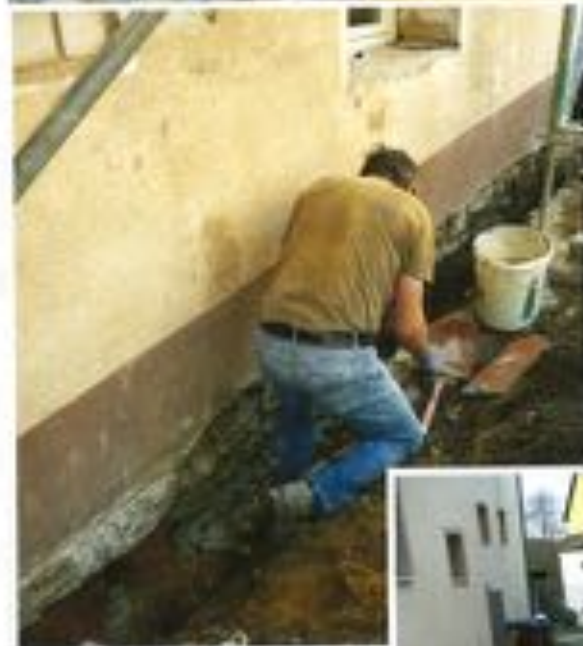
Jakob isoliert des Außensockel
