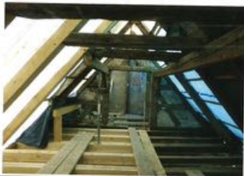
Das Dach im Mesnerhaus wird Bad, Schrankraum und Speicher
