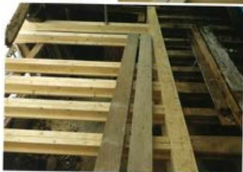
Bohlen-Balkendecke neu und alt
