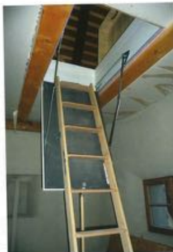
Zugtreppe in den Dachboden - Torhaus -
