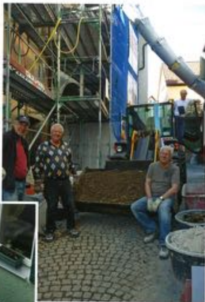
Staubiger Abraum aus den Zwischen- böden und Erdaushub
