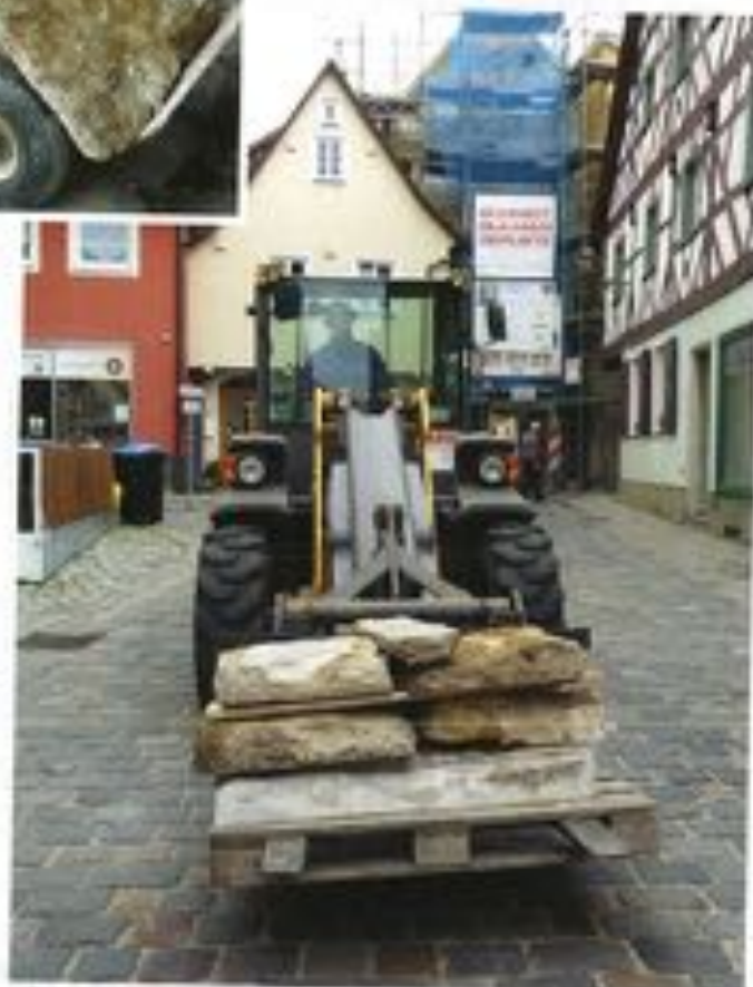
... und zur Wiederverwendung abtransportiert und zwischengelagert
