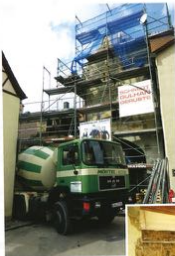
Einbringen der Betonbodenplatte im Erdgeschoß
