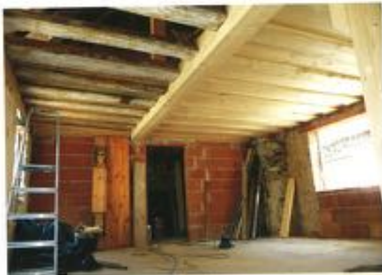
Die neue Deckenhälfte ist bereits fertig
