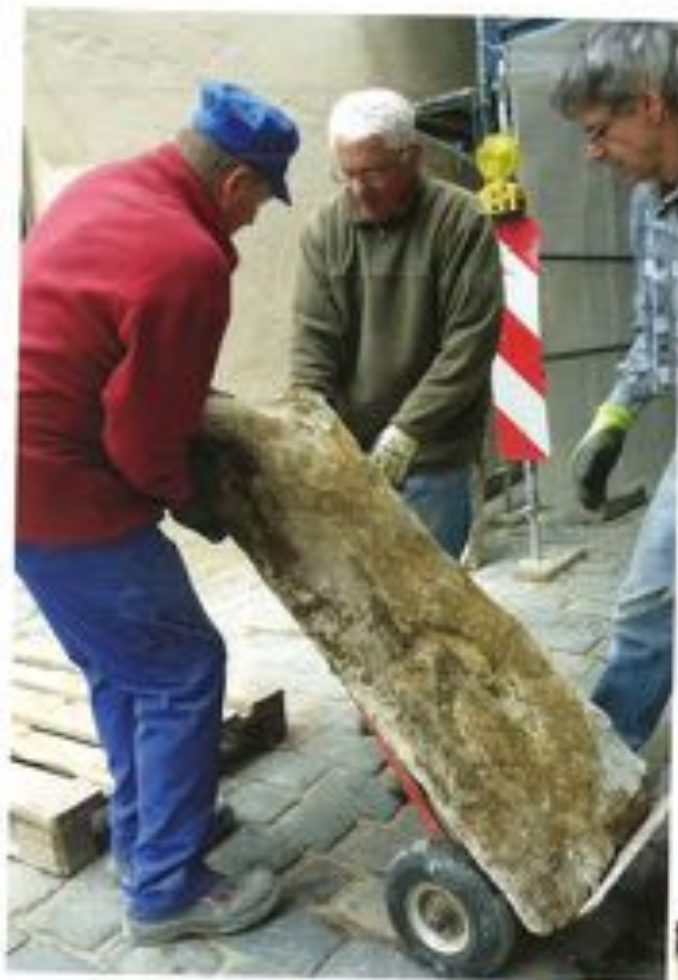
Die schweren alten Kalksteinplatten aus dem Mesnerhaus wurden vorsichtig geborgen...
