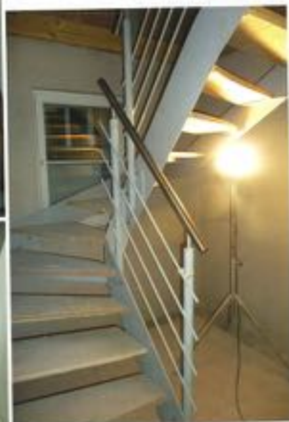
Die neue Stahl-Holz- treppe in den 1. Stock und zur Loggia im 2. Stock
